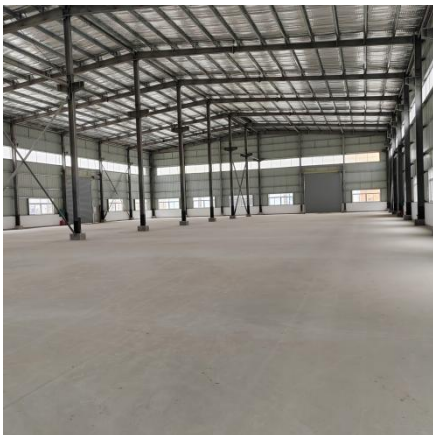
项目厂房现状
