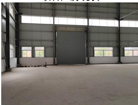
项目厂房现状
