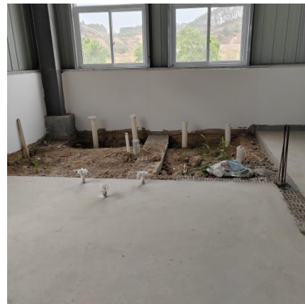
项目厂房现状
