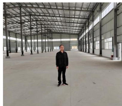
项目编制主持人现场踏勘照片
